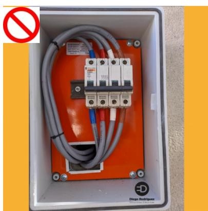
b) **Interruptor de control de potencia (ICP)** se ubica próximo al cajón medidor. Es **propiedad de UTE** y **únicamente puede levantarse si se dispara por sobrecarga o cortocircuito**. Lo instala y lo precinta UTE, sólo ellos pueden cambiarlo.
